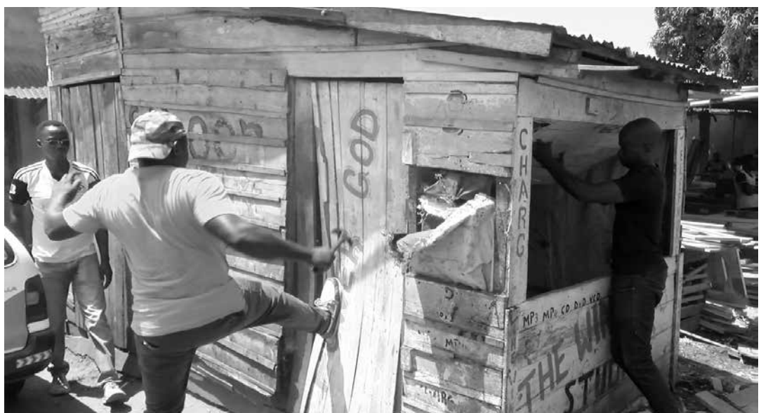
Démolition des kiosques dans la zone Buyenzi
